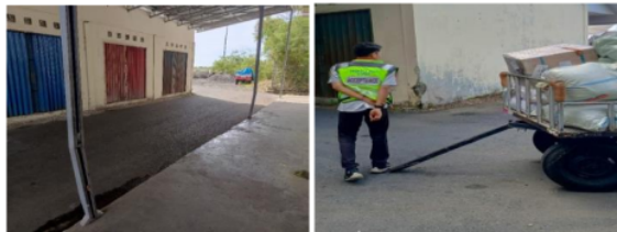
Gambar IV. 4 Kerusakan yang ditimbulkan
