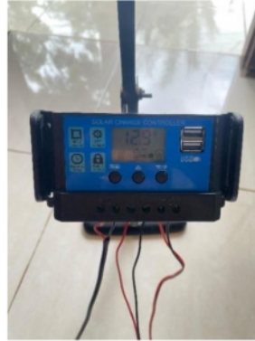
Gambar IV. 12 Pemasangan Kabel Lampu ke SCC
