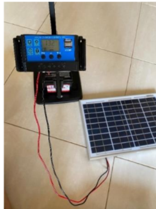
Gambar IV. 11 Pemasangan Kabel Solar Cell ke SCC
