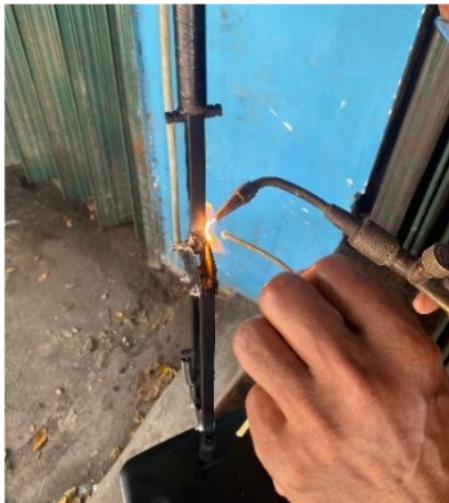
Gambar IV. 9 Pengelasan Tiang Lampu
