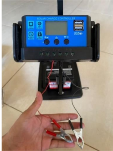
Gambar IV. 10 Pemasangan Kabel Baterai ke SCC
