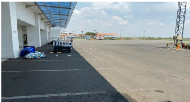
Gambar IV.5 Tumpahan FOD di Apron (Sumber: Dokumentasi Penulis)
