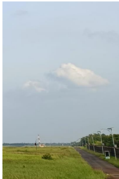
Gambar IV. 1 Penerangan jalan perimeter bandara
