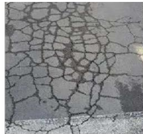
Gambar II. 4 Retak kulit buaya
