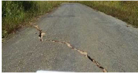
Gambar II. 27 Retak kehancuran ( Blow up )
