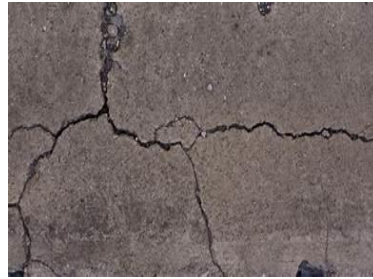
Gambar II. 5 Retak blok
