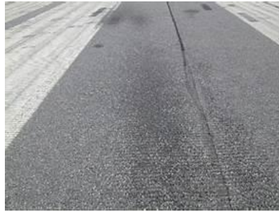
Gambar II. 11 Erosi semburan
