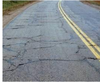
Gambar II. 3 Retak memanjang dan melintang
