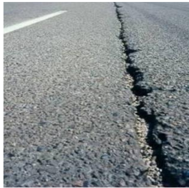
Gambar II. 20 Retak memanjang dan melintang
