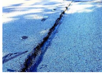
Gambar II. 32 Penurunan atau patahan ( Settlement/Faulting )
