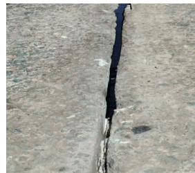
Gambar II. 31 Pemompaan ( Pumping )
