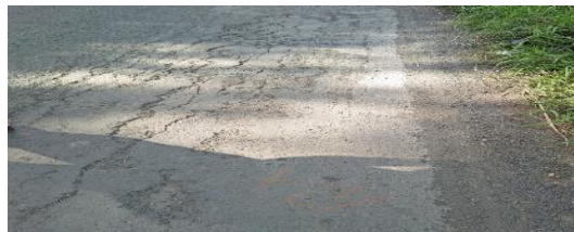
Gambar II. 15 Penurunan setempat
