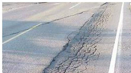
Gambar II. 13 Lendutan dijalur roda
