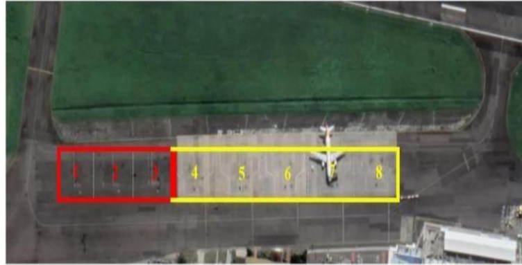
Gambar I. 1 Kondisi Existing Apron
