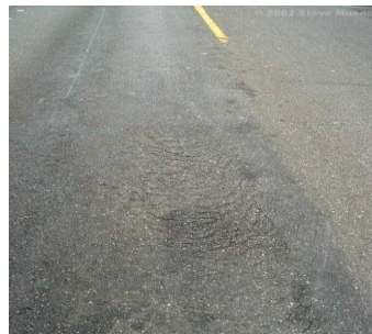
Gambar II. 6 Retak slip
