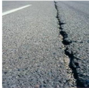
Gambar II. 20 Retak memanjang dan melintang
