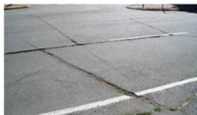
Gambar II. 7 Retak reflektif sambungan
