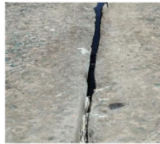
Gambar II. 31 Pemompaan ( Pumping )
