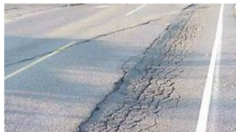
Gambar II. 13 Lendutan dijalur roda
