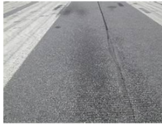
Gambar II. 11 Erosi semburan
