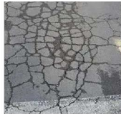
Gambar II. 4 Retak kulit buaya
