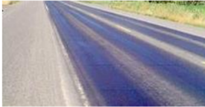
Gambar II. 19 Keluarnya material aspal ke permukaan
