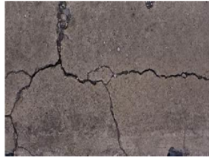
Gambar II. 5 Retak blok
