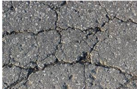
Gambar II. 24 Retak susut
