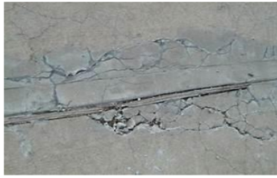
Gambar II. 23 Retak daya tahan
