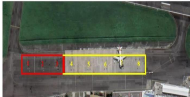
Gambar I. 1 Kondisi Existing Apron (Sumber : Google Earth, 2024)
