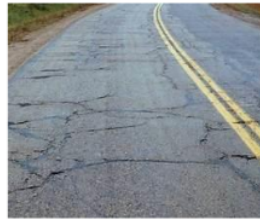
Gambar II. 3 Retak memanjang dan melintang
