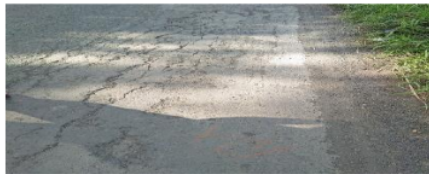
Gambar II. 15 Penurunan setempat
