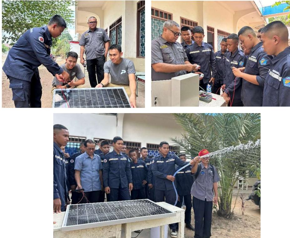
Gambar 3. 3 Praktik Pemasangan Instalasi Pompa Air dengan Tenaga Surya
