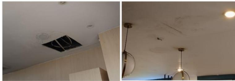
Gambar II.1 Kebocoran bangunan di Terminal 1
