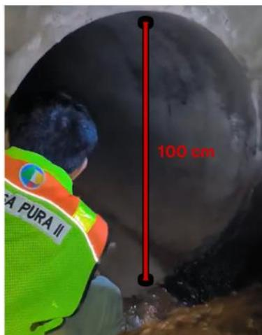
Gambar II. 1 Inspeksi Saluran Air Tertutup di Bandara SMB II Palembang
