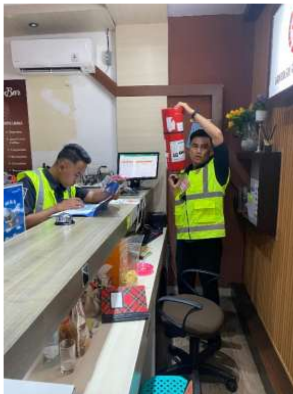
Gambar inspeksi dan perawatan APAR
