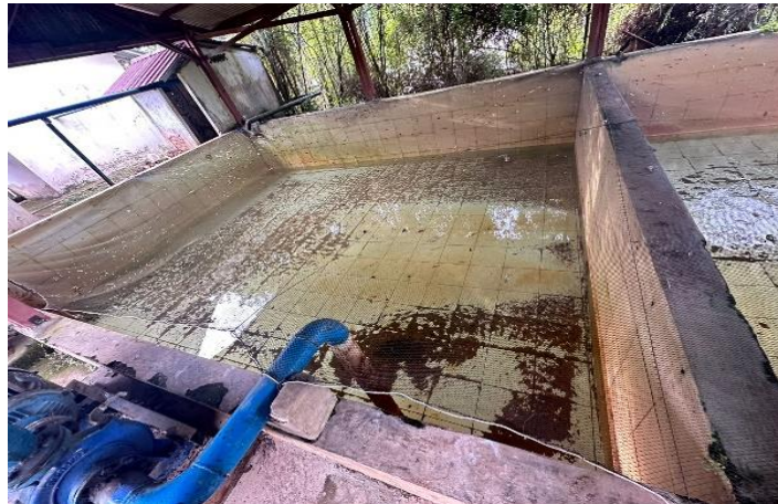
Gambar II. 2 Bak Reservoir Air Bersih SMB II Palembang (Sumber: Dokumentasi Penulis, 2025)
