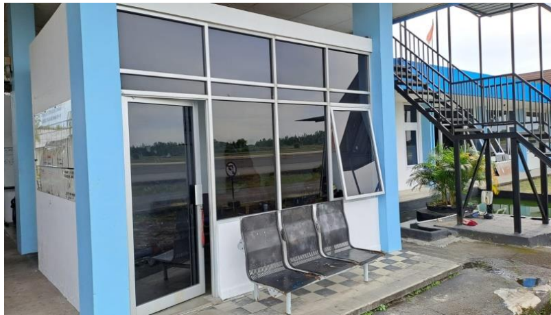
Watchroom tampak luar
