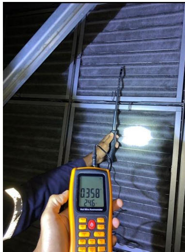
Gambar II. 1 Pengukuran Air Velocity pada AHU
