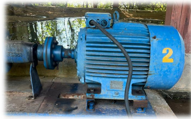
Gambar II. 2 Motor Induksi 3 Fasa (Sumber : Unit TTEQ Injourney Airport Bandara SMB II PLM)
