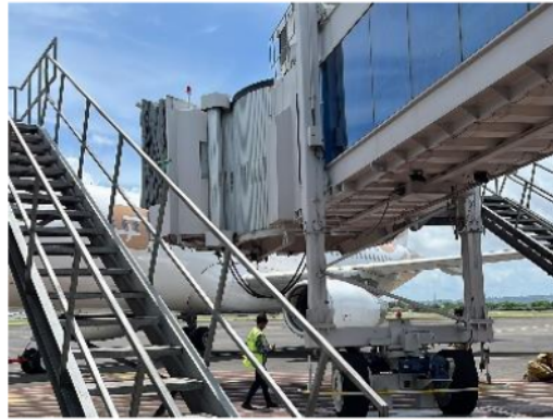
Gambar II. 1 Aviobridge Sumber : Dokumentasi Penulis
