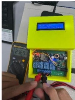
Gambar IV. 50 Uji tegangan Aviobridge failure (relay 2) Sumber:penulis
