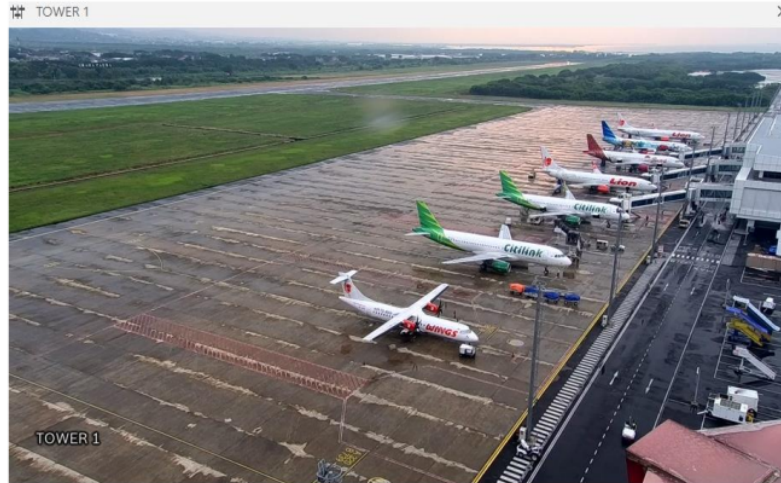
Gambar II. 3 Kondisi Apron Bandar Udara (Sumber: CCTV, 2023)
