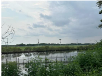
Gambar IV. 4 Lampu Penerangan yang hanya terdapat pada Zona C
