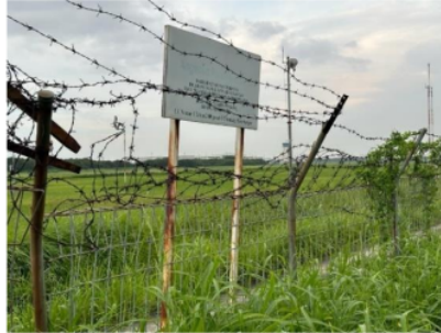
Gambar IV. 2 Kawat Duri yang Mengalami Korosi
