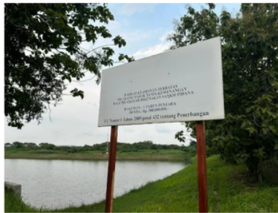
Gambar IV. 6 Sign Board Peringatan yang Belum Sesuai dengan Standar
