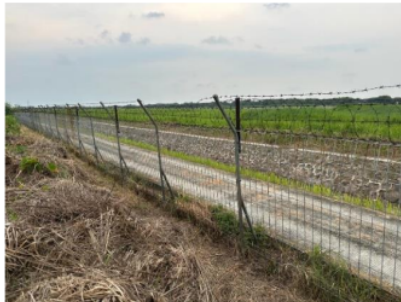
Gambar IV. 3 Tidak Tersedia Fasilitas CCTV pada Area Pembatas Fisik
