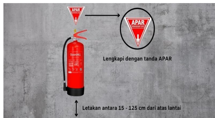
Gambar 2.9 Penempatan APAR
