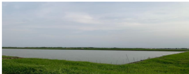
Gambar IV. 2 Kolam Penampungan Air dan Ujung Drainase (Penulis, 2024)
