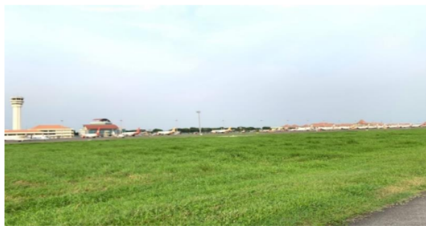
Gambar IV. 5 Area Pinggiran Taxiway Pont Timur (Penulis, 2024)
