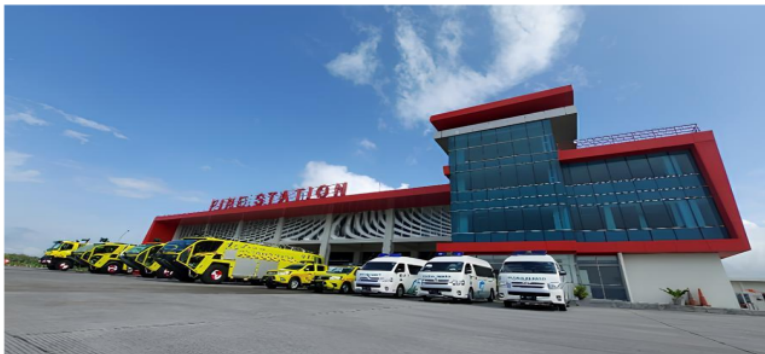
Gambar IV. 1 Fire Station Bandar Udara Internasional Yogyakarta
