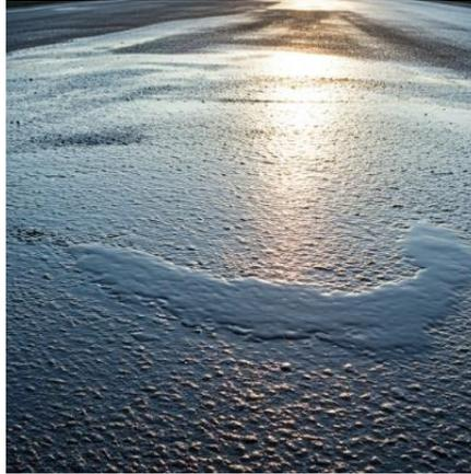
Gambar II. 2 Kerusakan *Bleeding* pada Permukaan Perkerasan
