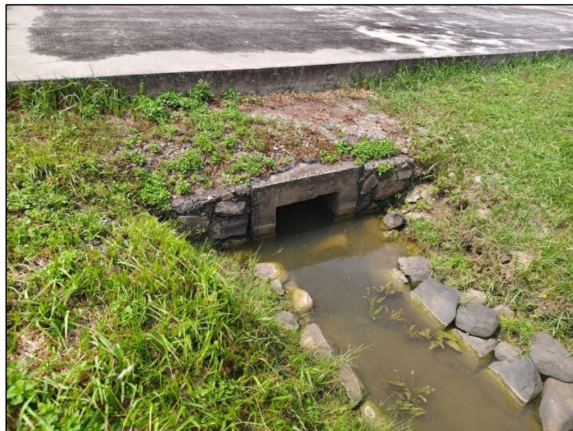
Gambar I. 1 Box Culvert Pada Taxiway Alfa, Bravo, dan Charlie (Sumber: Bandara Jenderal Ahmad Yani Semarang, 2026)
