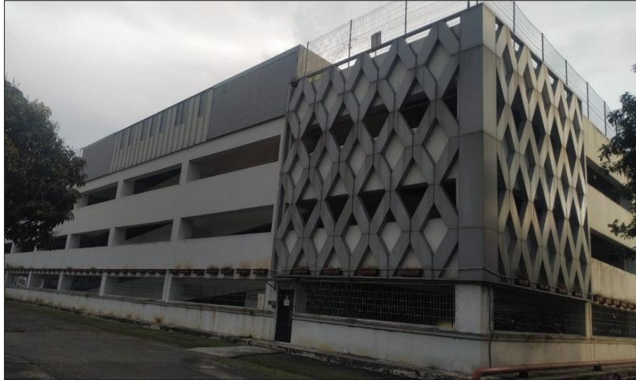
Gambar I. 1 Gedung Parkir Bertingkat Bandara Radin Inten II Lampung (Sumber: Bandara Radin Inten II Lampung, 2026)
