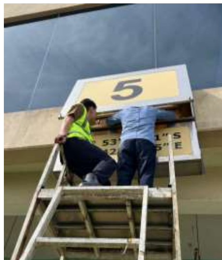
Gambar I. 1 Perbaikan lampu ASIS (Sumber: Penulis, 2025)
